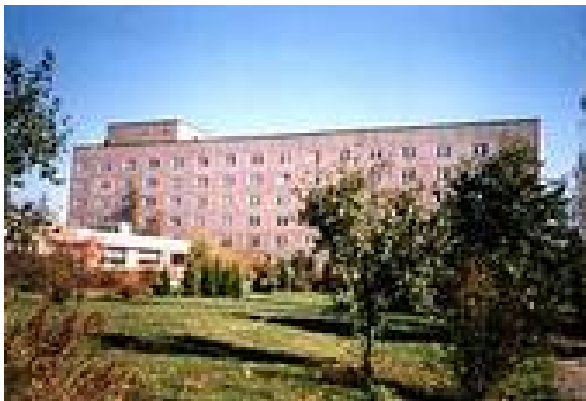
Seniorenzentrum vor dem Umbau
